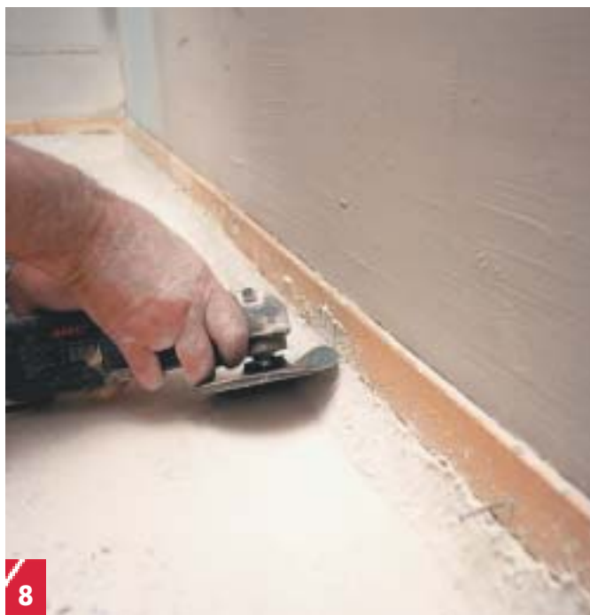
8 For at komme ordentligt til, når hulkelen skal slibes, skal du forsyne vinkelsliberen med en slibeskive på en fleksibel gummiskive.
