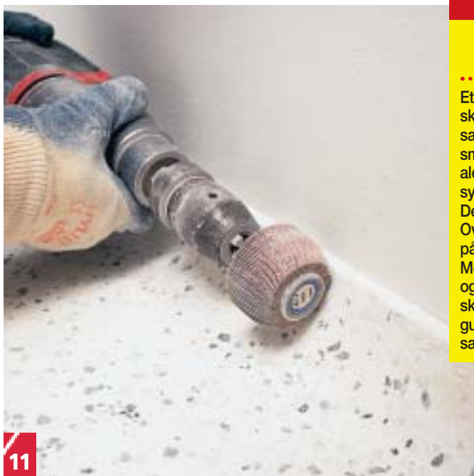
11 Til hulkelens kanter er en lamelsliber på boremaskinen mest velegnet, mens du kommer bedst ind i hjørnerne med en slibestift (også kaldet en karborundumsten), der sættes på din boremaskine.
