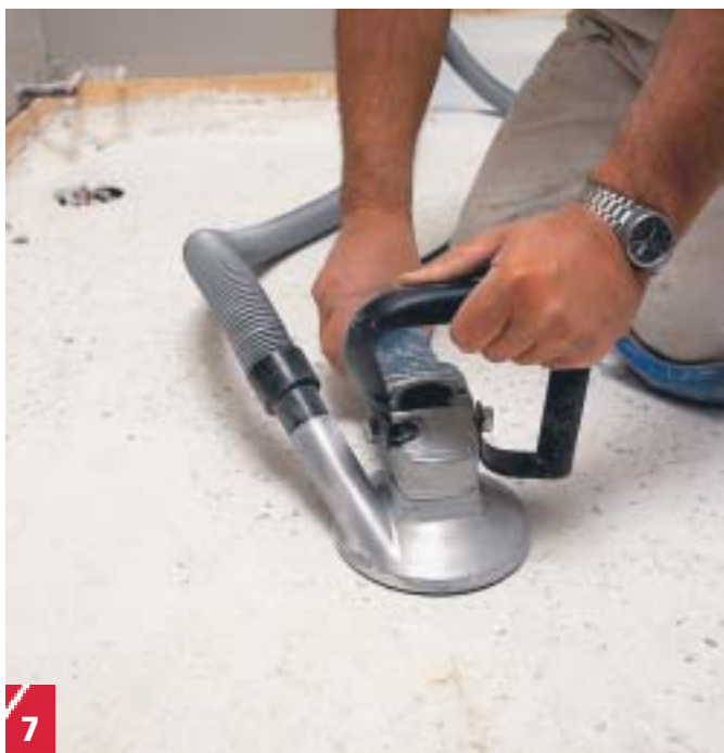
7 En vinkelsliber med diamantskive gør det indledende grove slibearbejde. Slib herefter med almindelige slibeskiver (korn 60).
